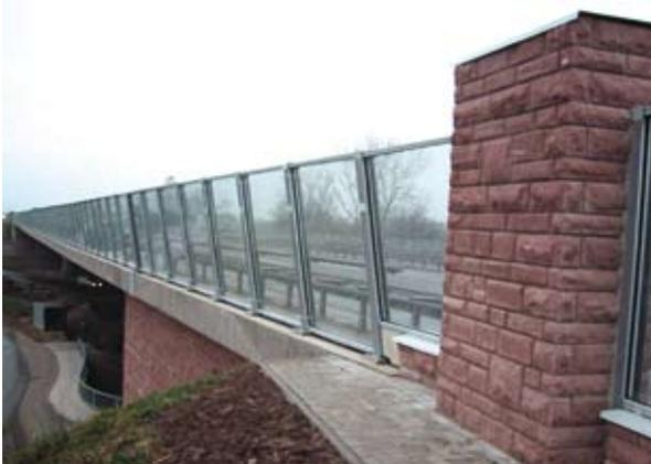
Abbildung 31: Zur Vermeidung von Schall- und Lichtreflexionen nach außen geneigte Glaswand auf einer Brücke (Foto R. Kohlauer GmbH),
