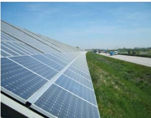
Abbildung 39: Lärmschutzwand mit aufgesetzter Photovoltaikanlage (Foto Kühne)
