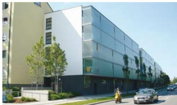
Abbildung 42: Verbesserung des Schallschutzes durch zusätzliche Abschirmung (Foto Kühne)
